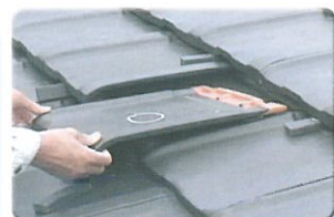
平瓦の引抜き
