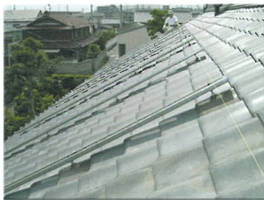
縦桟の取付け▶
