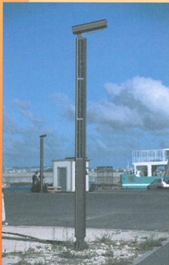
沖縄県宮古郡伊良部島
